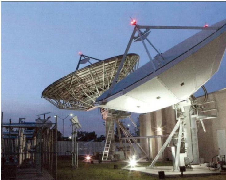
Al paso del tiempo nuevas antenas, de menores dimensiones y conectadas a satélites mexicanos como el Morelos 3, hicieron más eficiente el trabajo de la estación terrena de Tulancingo. SICT.
