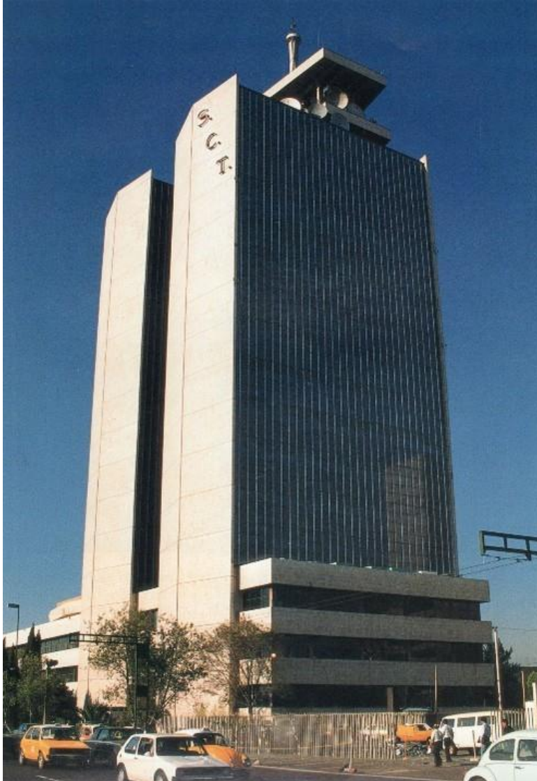
Emblemática torre de Comunicaciones construida en terrenos del Centro SCOP. SICT.
